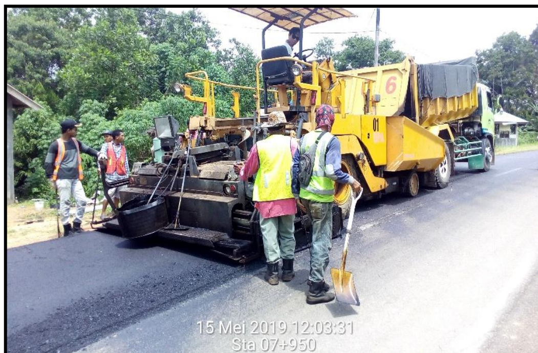
Gambar 1. 5 Ruas Jl. Simp.Pengudang – Simp.Lagoi Segmen 1
