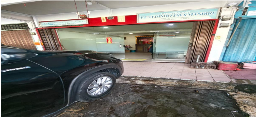
Gambar 1. Gedung Kantor PT. Tedindo Jaya Mandiri Tanjungpinang
